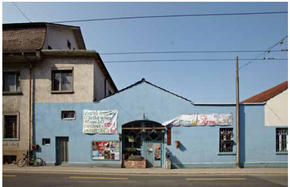
Geissensteinring 15: Ansicht von Südosten
