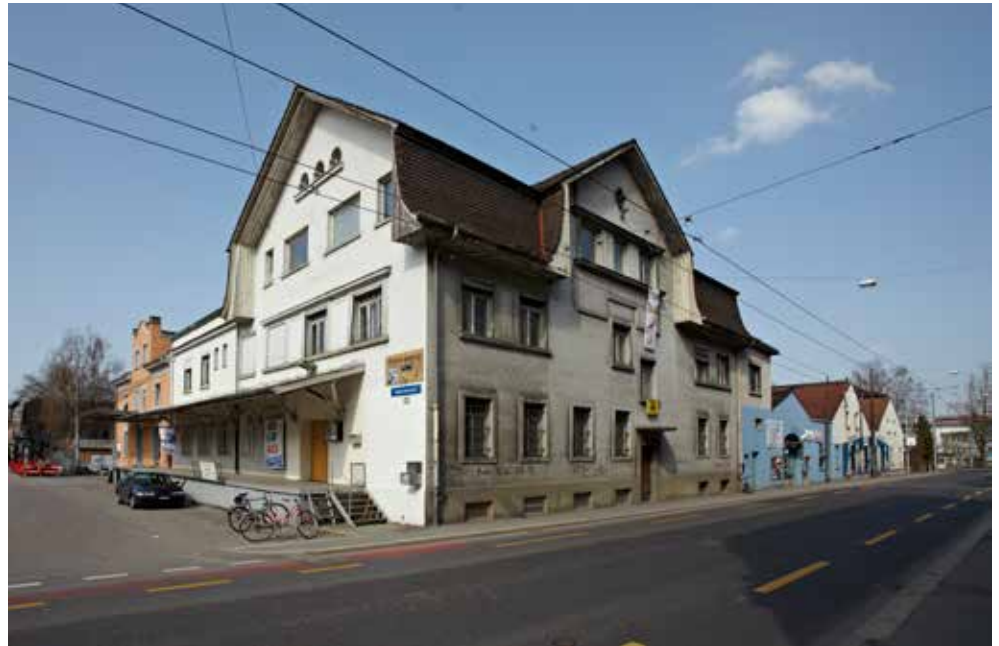
Industriestrasse 17: Ansicht von Süden
