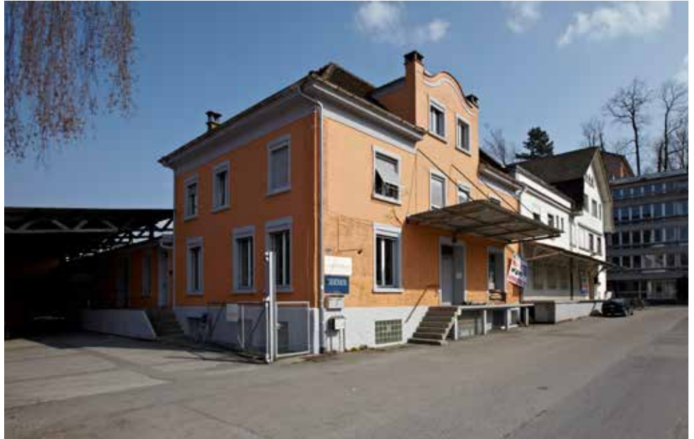
Industriestrasse 15: Ansicht von Westen
