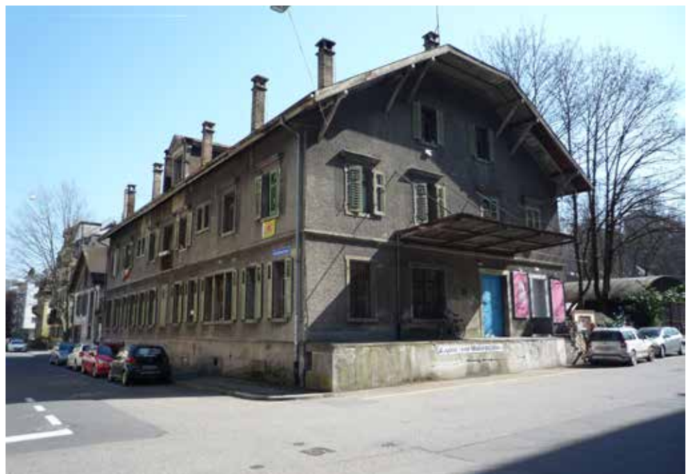
Industriestrasse 9: Ansicht von Südwesten
