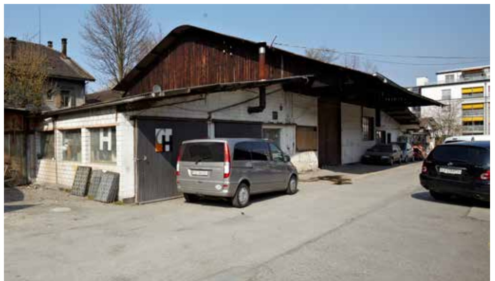
Industriestrasse 11: Ansicht von Südwesten
