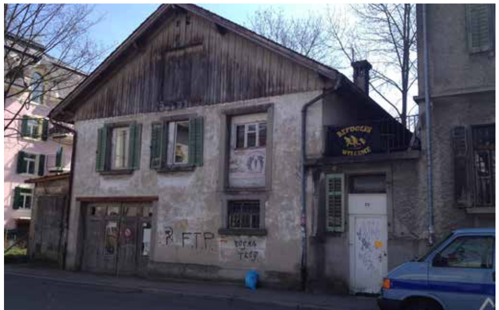
Industriestrasse 9a: Ansicht von Norden
