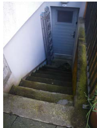
Zugang zum Keller von aussen
