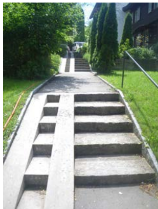
Rampen zu höher gelegenen Wohnungen
