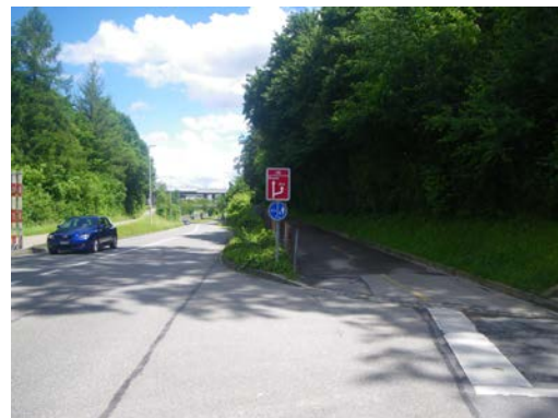
Trennwirkung durch Freiburgstrasse
